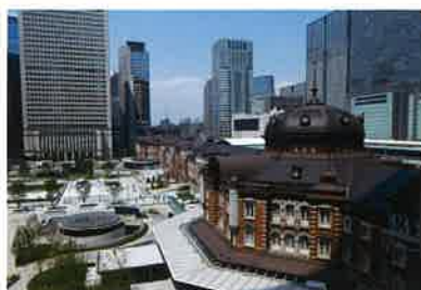
◀ 東京駅と丸の内駅前広場
